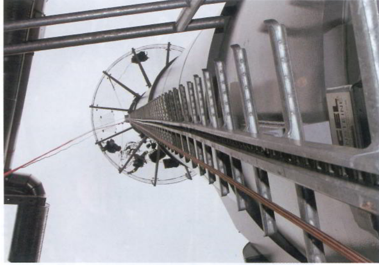
Abb. 4: Lebensversicherung für die Retter: Zugangs- und Sicherungsselle für den Auf- und Abstieg
